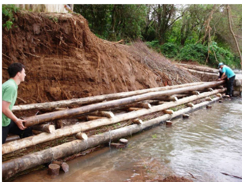
Figura 15: Construção da parede-Krainer (set/2005). Fonte: Sutuli, 2007.
