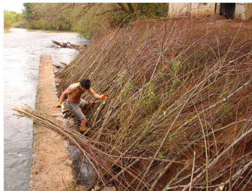
Figura 13: Colocação dos ramos para confecção da esteira viva (ago/2005). Fonte: Sutuli, 2007.
