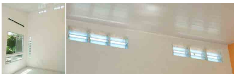
Fig. 3 –Tijolo "capelinha", usado junto ao teto (E). À direita, em detalhe.
