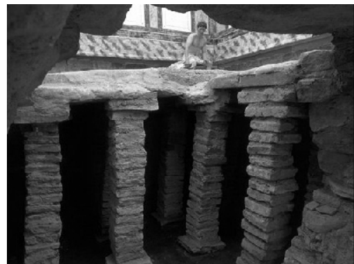
Figura 4 - Ruínas romanas mostrando as túneis do subsolos e suas colunas. Fonte: Deal-Heating (2009).
