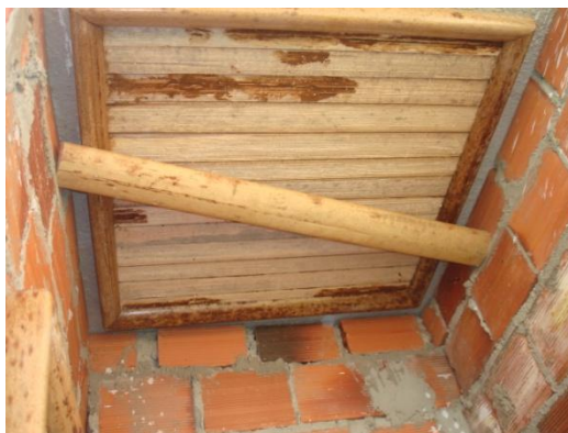
Figura 05 – Painel de buriti na parte interna da laje de cobertura
