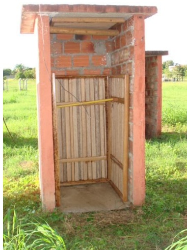
Figura 06 – Protótipo com painéis de buriti nas paredes laterais internas
