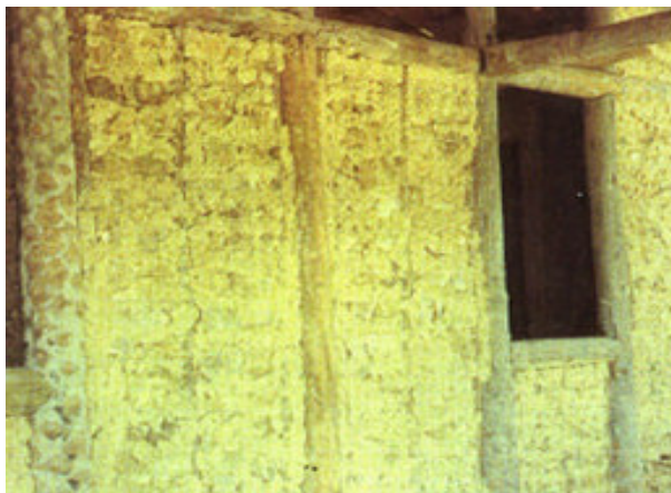
Figura 5 - Segunda camada de terra, correspondente ao emboço da construção no bairro Piçarra. Foto Paulo Frota (1984)
