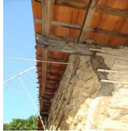
Figura 2 - Beirais estreitos e paredes sem revestimento da construção no bairro Morada do Sol. Foto: Thaís Carvalho (2009).
