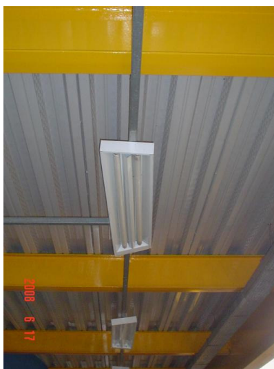
Figura 7 – Detalhe falta de manutenção: luminárias contorcidas.
