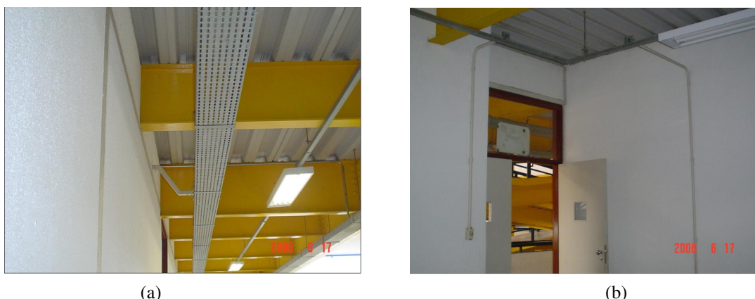
Figura 1 – Ramificação do sistema predial de energia elétrica. (a) Subsistema eletrocalhas; (b) subsistema eletrodutos.
