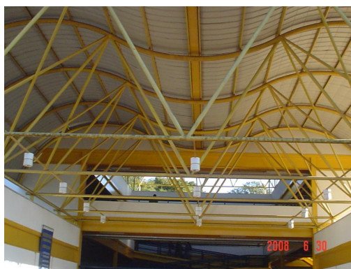
Figura 6 – Sustentação das luminárias do átrio
