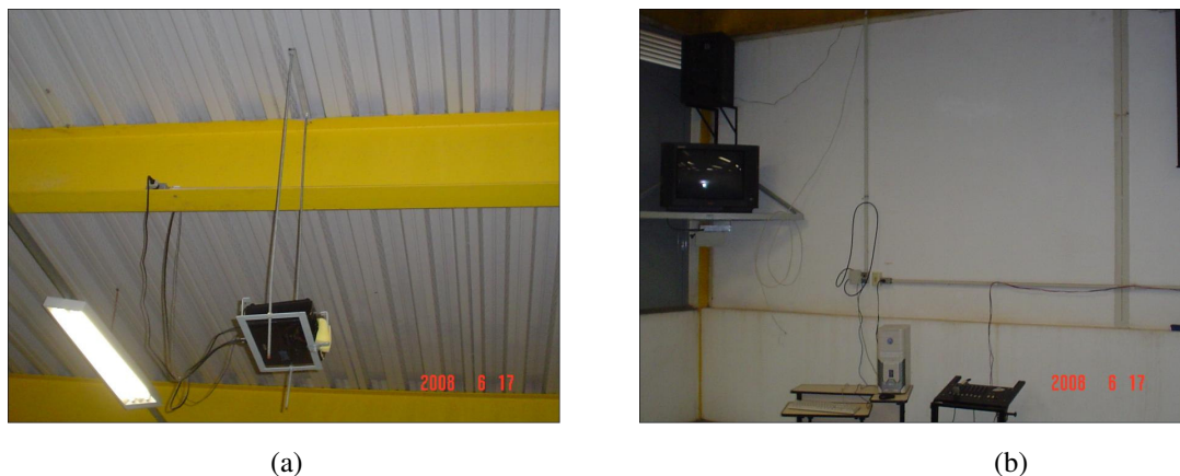
(a) (b) Figura 2 – (a) detalhe para “T” fazendo a ligação entre o equipamento e a instalação elétrica; (b) detalhe para a fixação dos equipamentos pendurada nas tubulações (b)
