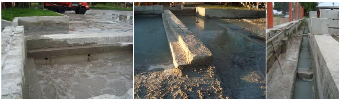
Figura 6 – Processo de decantação para reaproveitamento da água de lavagem
