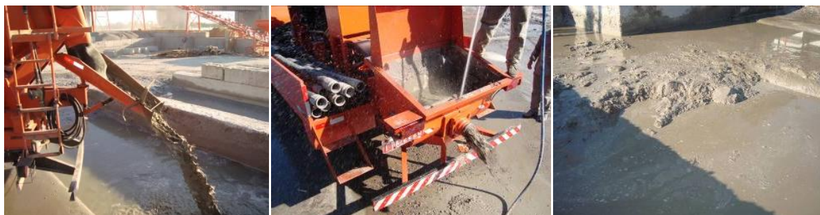
Figura 3 – geração do resíduo em centrais dosadoras de concreto
