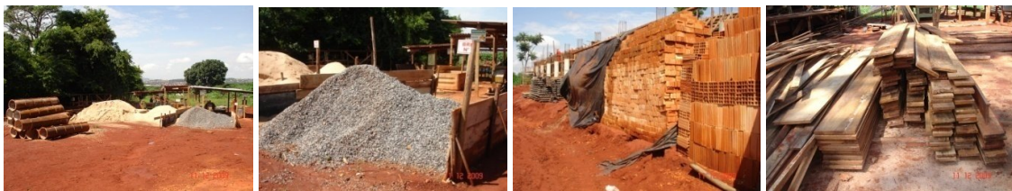
Figura 6 – Materiais erroneamente armazenados diretamente sobre o piso de terra batida
