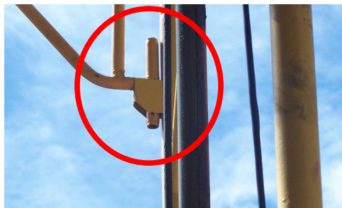
Figura 3 – Ausência de contrapinos nos contraventos de torre de elevador
