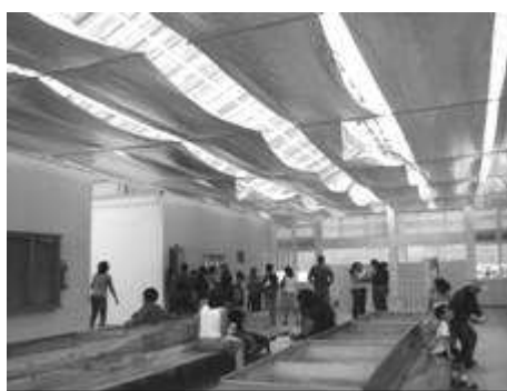
Figura 3 – Prefeitura de Mariana - Hall do segundo pavimento (cobertura em policarbonato com lonas revestidas em alumínio polido).
