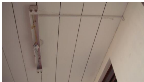
Foto 7 - Falta de manutenção no sistema de iluminação artificial (Escola A). Fonte: acervo pessoal.
