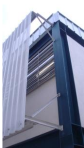
Foto 3 (esquerda) – Escola B: Proteção solar fachada oeste: para o vão entre a fachada e a tela perfurada. Foto 4 (centro) – Escola B: Inexistência de dispositivos para proteção solar na fachada leste (vista do exterior). Foto 5 (direita) – Escola B: Improvisação de elementos para proteção solar nas salas de aula orientadas para leste (vista do interior).
