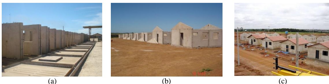
Figura 4 – Montagem das Habitações Residencial Real Conquista (a) Paredes prontas estocadas e gabarito de execução. (b) Oitões prontos e estocados. (c) Habitação concluída. (Fonte: JETCASA, 2010)
