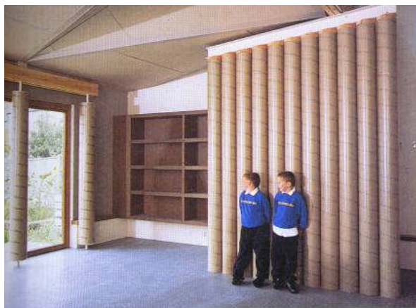
Figura 2 – Clube de música pós-aula construído com tubos de papelão, Inglaterra – vista interna. Fonte: Slessor, 2002, p.57.
