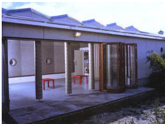
Figura 3 – Clube de música pós-aula construído com tubos de papelão, Inglaterra – vista externa. Fonte: Slessor, 2002, p.57.
