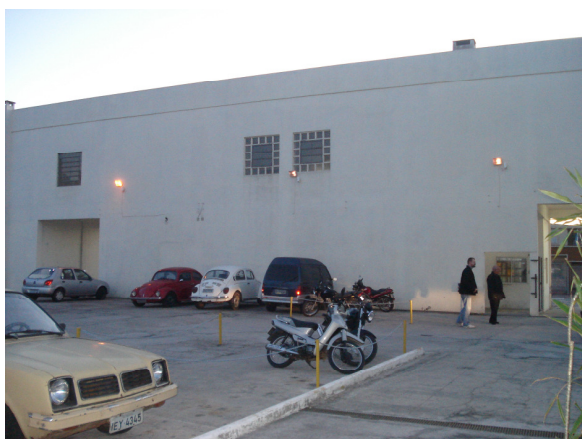
Figura 3 - Três refletores não previstos no projeto
