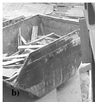
Figura 2 - Problemas da gestão de resíduos: a) obra C - mistura de resíduos na fonte, b) obra D - única caçamba na obra para o acondicionamento da madeira
