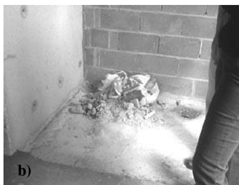
Figura 1 - Problemas da gestão de resíduos: a) obra A - bags de plástico aguardando definição de coletor, b) obra B - resíduos misturados em saco
