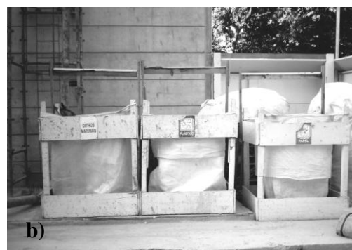
Figura 3 - Problemas da gestão de resíduos: a) obra E - baia com mistura de gesso, papel e plástico; b) obra F - bags sem cobertura
