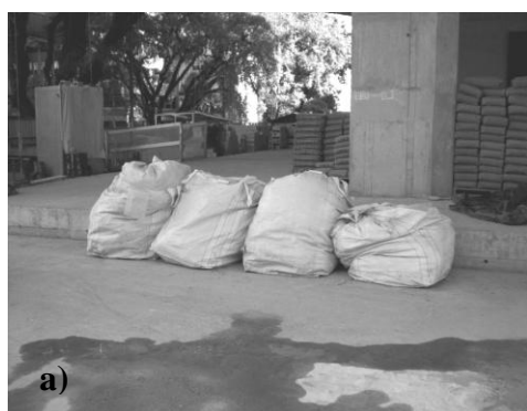
Figura 1 - Problemas da gestão de resíduos: a) obra A - bags de plástico aguardando definição de coletor, b) obra B - resíduos misturados em saco
