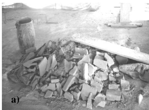
Figura 2 - Problemas da gestão de resíduos: a) obra C - mistura de resíduos na fonte, b) obra D - única caçamba na obra para o acondicionamento da madeira
