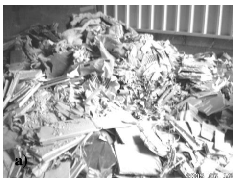
Figura 3 - Problemas da gestão de resíduos: a) obra E - baia com mistura de gesso, papel e plástico; b) obra F - bags sem cobertura
