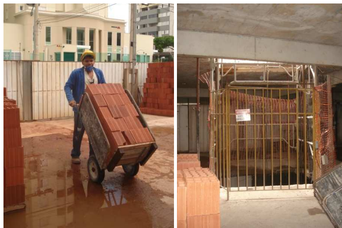
Figura 3- Transporte vertical e horizontal na obra da empresa D
