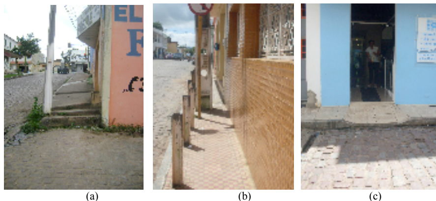
Figura 2 – Desníveis(a), obstáculos na circulação(b), rampa inadequada(c), encontrados nas calçadas da Zona Central de Palmeira dos Índios.
