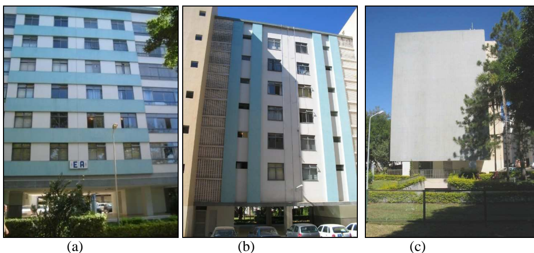
Figura 5 – Junta estrutural existente entre blocos (a), detalhe do pano de elementos vazados (b) e empena (c) do edifício B
