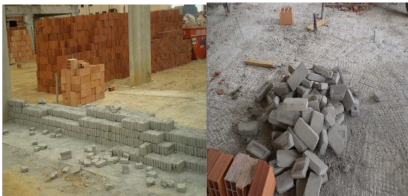
Figura 5 – Exemplo de desperdício dos materiais envolvidos nos processos de alvenaria
