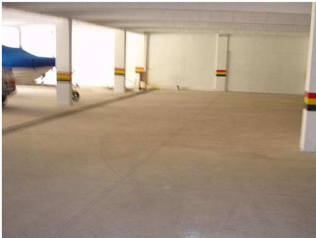
Figura 3 - Local de aplicação do entulho – pavimentação garagem
