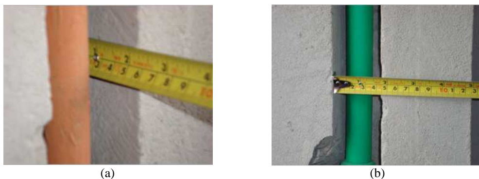
Figura 3 - (a) Espessura do reboco em pontos escolhidos aleatoriamente; (b) largura das canaletas para embutimento de tubulações hidráulicas em pontos escolhidos aleatoriamente
