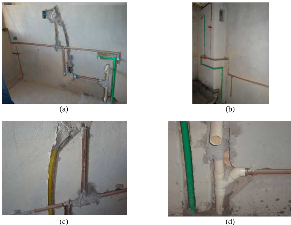
Figura 2 - (a), (b), (c), (d) Instalações elétricas e hidráulicas embutidas no revestimento de argamassa e na alvenaria
