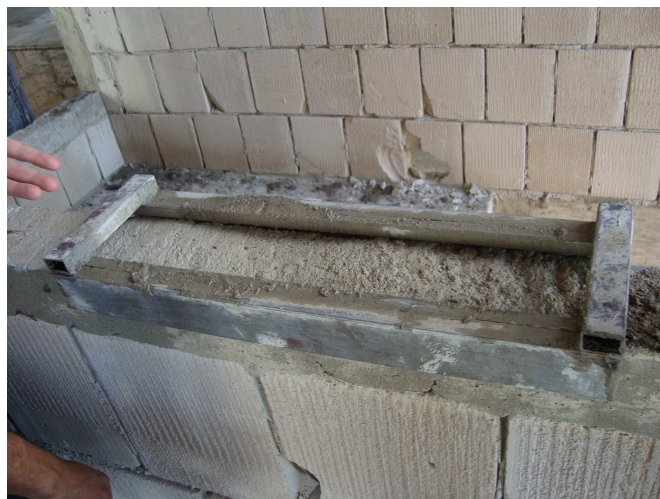
Figura 8 - Ferramenta criada na obra para assentamento de blocos em um dos canteiros de obra
