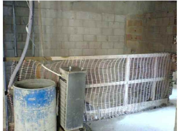
Figura 10 – Exemplo de proteção em madeira com três travessões e tela no poço do elevador da obra da construtora
