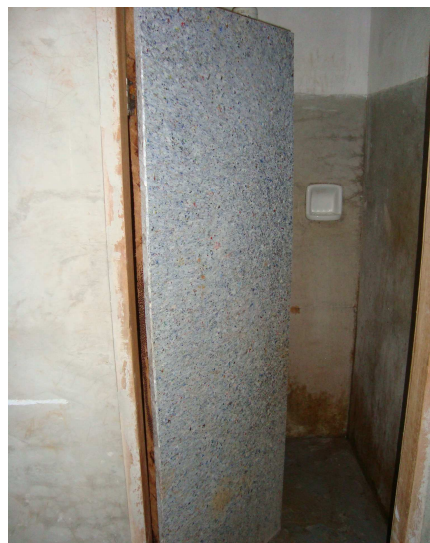
Figura 16 - Porta com material reciclado no banheiro dos funcionários do canteiro de obras
