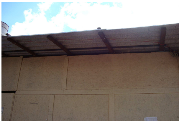
Figura 15 - Telha com material reciclado cobrindo alboxarifado
