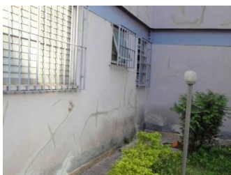
Figura 8 - Fissuras e umidade ascensional.
