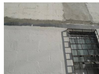
Figura 21 - Argamassa aplicada sobre fissura na interface estrutura-alvenaria e janela substituída (canto superior direito).
