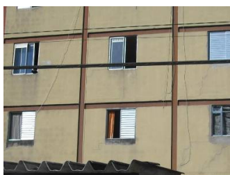
Figura 14 - Fissuras próximas às janelas e blocos com umidade.
