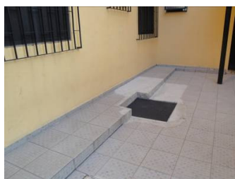
Figura 5 - Reforma das tubulações danificadas pelo recalque
