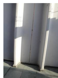
Figura 24 - Juntas mal vedadas, por onde há infiltração.
