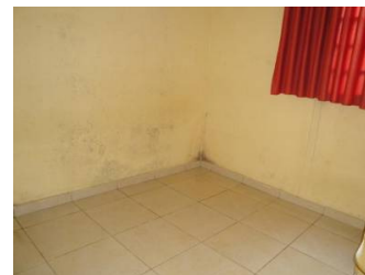
Figura 18 - Bolor nas paredes do apartamento.
