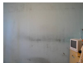
Figura 3 - Concentração de microorganismos na face interior da parede de fachada.
