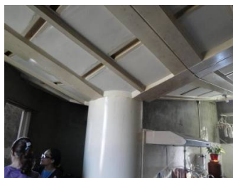
Figura 20 – Aspecto interno do apartamento. Grelha metálica com pontos de corrosão.
