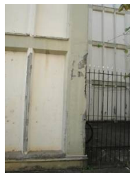
Figura 17 - Armaduras expostas.
