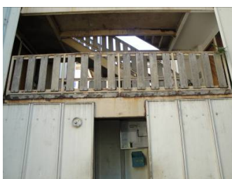
Figura 11 - Corrosão generalizada da estrutura na caixa de escada.
