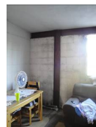
Figura 15 - Mofo e infiltrações na interface estrutura-alvenaria.
