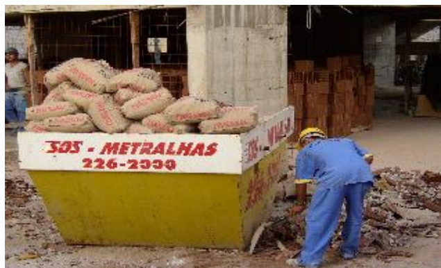
Figura 3 - Disposição da caçamba no interior do canteiro de obras
