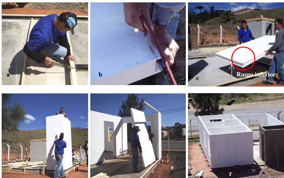
Figura 3- Montagem das paredes
