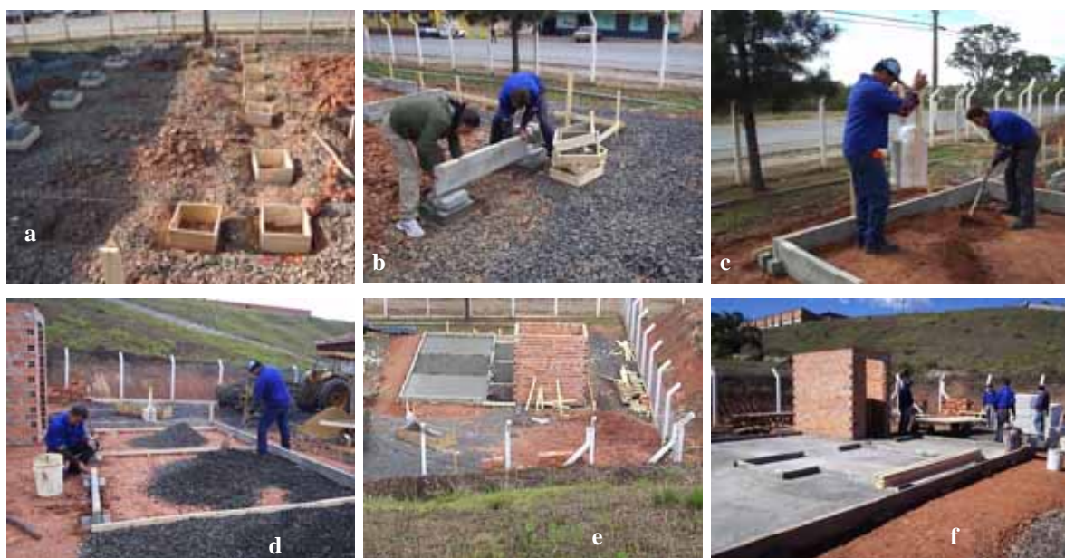
Figura 2- Execução da fundação e contrapiso
