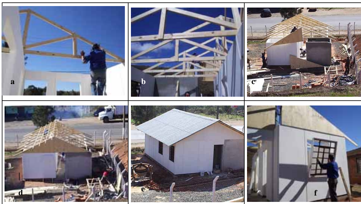
Figura 4- Montagem da cobertura
