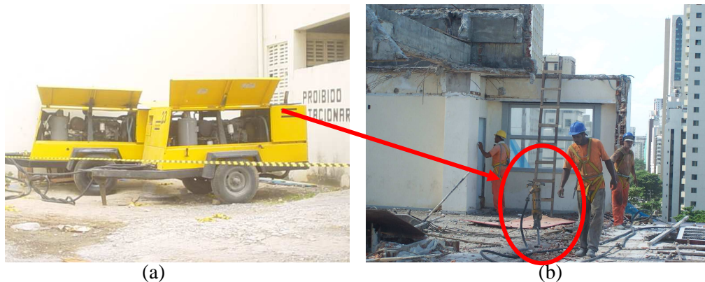
Figura 3 – Demolição por martelo pneumático: compressores de ar (a) e demolição por martelete (b) (Fonte: pesquisa de campo)
