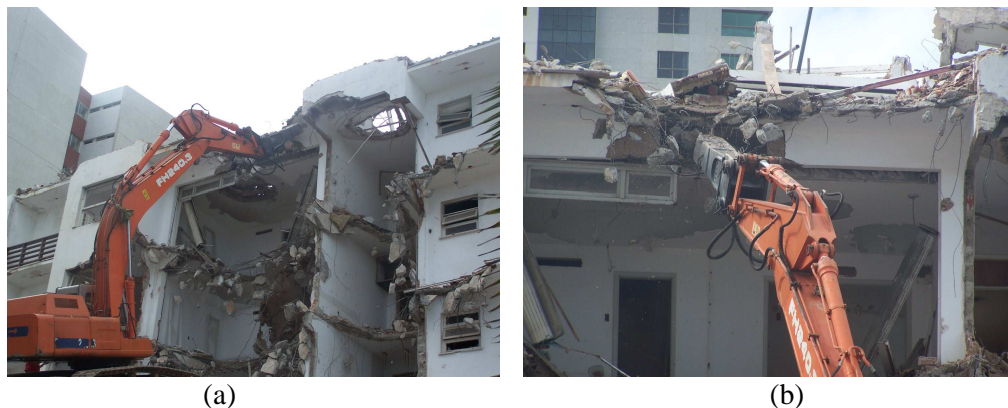
Figura 4 – Demolição mecanizada: (a) e (b) (Fonte: pesquisa de campo)
