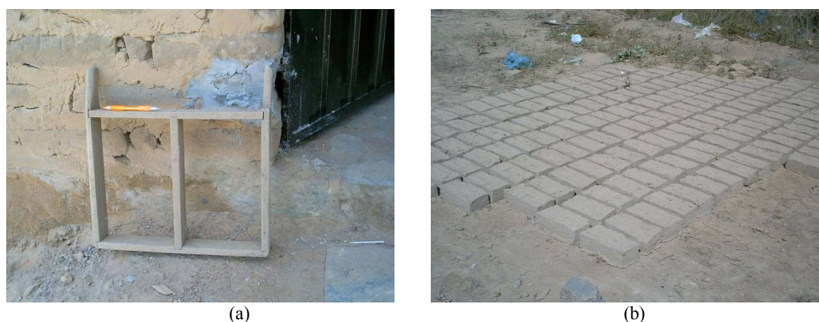
Figura 4. Fôrma de madeira utilizada na confecção dos adobes (a). Adobes distribuídos em terreno regularizado para secar ao sol (b).
