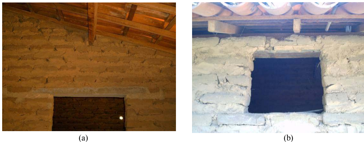
Figura 3. Detalhe da verga de concreto sobre o vão da porta (a) e da tábua colocada no vão do cobogó, que será retirada posteriormente (b).
