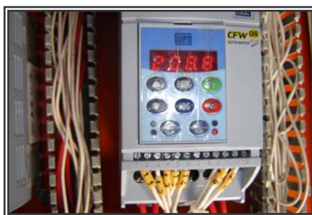
Figura 5 - Inversor acusando velocidade de 208,8 rpm Fonte: Arquivo dos autores
