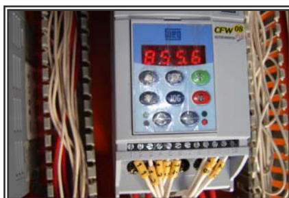
Figura 6 - Inversor indicando velocidade de 855,6 rpm
