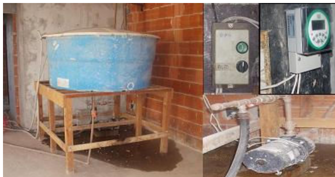
Figura 1 - Dispositivo para cura automática do concreto
