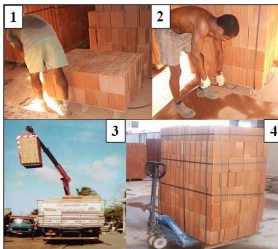
Figura 5 - Paletização, entrega e movimentação de lajotas dentro dos canteiros de obras
