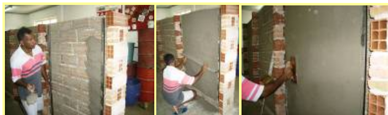
Figura 1 - Principais etapas da aplicação da argamassa.
