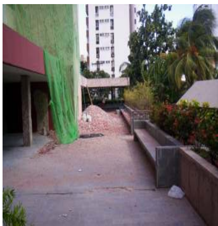
Figura 4 - Problemas identificados no térreo da obra da empresa B: falta de sinalização referente ao risco oferecido pela obra, deficiente fixação da tela de fachada, local sem restrição de circulação de pessoas.
