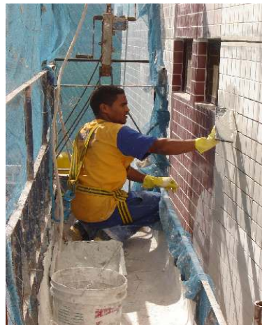
Figura 2 – Funcionário executando a aplicação do rejunte com a luva de borracha, porém sem a utilização do capacete - obra E.
