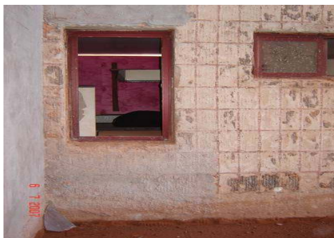
Figura 3 – Vidraçaria danificada devido à proteção ineficiente das esquadrias (utilização de papelão) na edificação da obra E.
