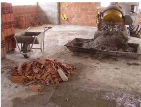
Figura 1: Situação de desperdício de blocos cerâmicos na execução do serviço de alvenaria
