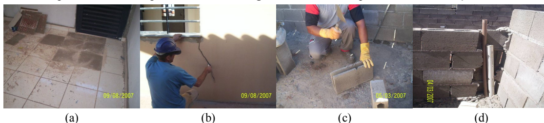
Figura 2 – Problemas comuns observados em campo (a) cerâmica “choca”; (b) trincas na alvenaria; (c) falta de modulação da alvenaria; (d) quebra da alvenaria para instalação elétrica / hidro-sanitária.
