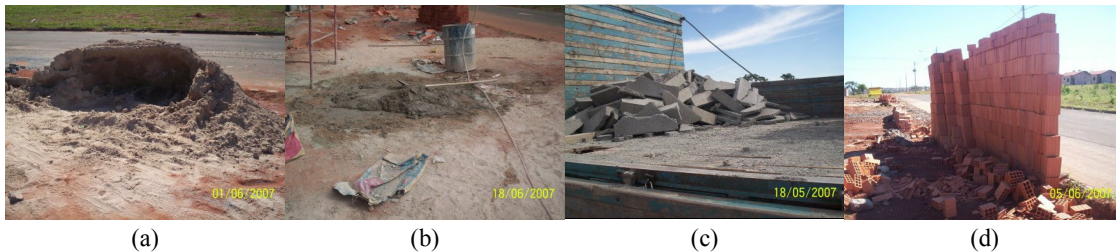
Figura 3 – Armazenamento e estocagem de materiais observados em campo (a) areia; (b) argamassa executada manualmente diretamente no chão; (c) blocos de concreto de baixa qualidade; (d) tijolo cerâmico.
