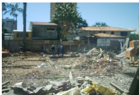
Figura 14 – Solo sendo reutilizado como reaterro no canteiro.
