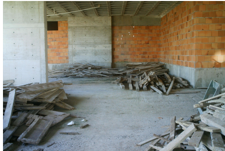
Figura 12 – Madeira selecionada para reutilização na confecção de fôrmas.
