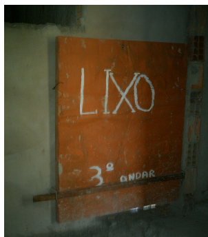
Figura 11 - Duto de ventilação sendo utilizado no transporte vertical de RCD.
