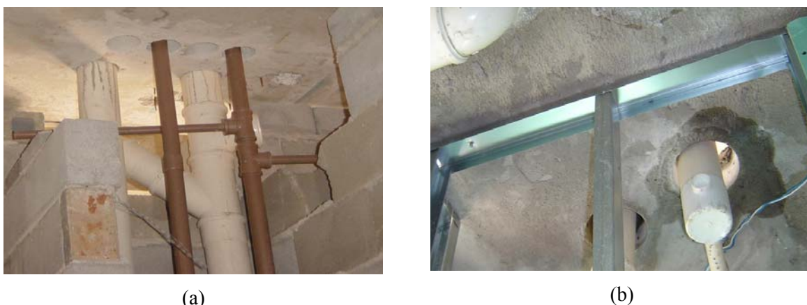
Figura 4 – Shaft com perfurações maiores que os diâmetros dos tubos de água fria (a) e de caixa seca (b).
