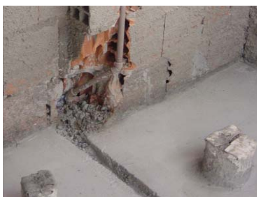
Figura 3 – E execução de transição parede piso sem nenhuma proteção que desvincule tubulação da estrutura e alvenaria na obra F.
