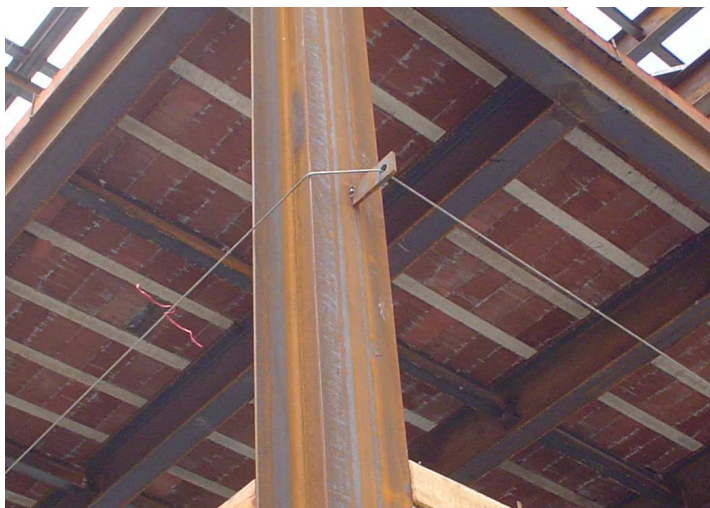
Figura 2 – Cabos de aço fixados em acessórios soldados no pilar
