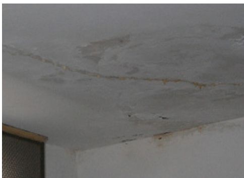
Figura 5 - Formação de estalactites devido a lixiviação na laje da garagem
