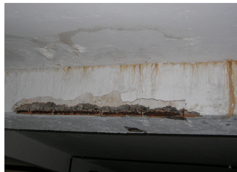
Figura 4 – Cobrimento deficiente, corrosão acentuada e eflorescência na garagem.
