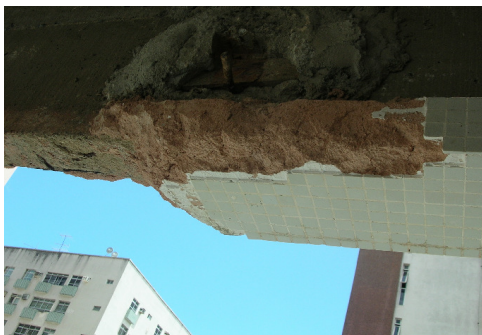
Figura 7 - Descolamento de revestimento com espessura excessiva de saibro
