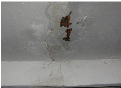
Figura 3 – Cobrimento deficiente e corrosão em laje do pavimento garagem.
