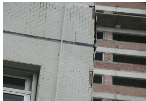
Figura 8 – Descolamento do revestimento de Fachada.
