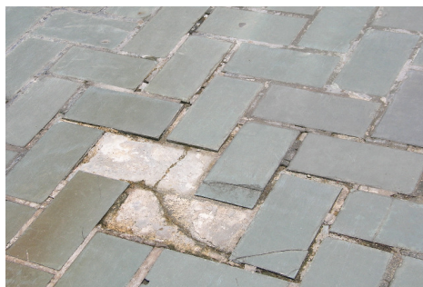
Figura 2 – Piso do pilotis com descolamento cerâmico.
