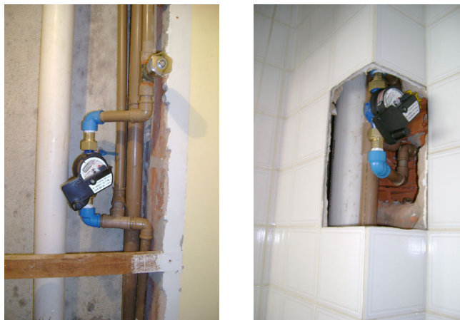
Figura 1 – Instalação do hidrômetro individual.
