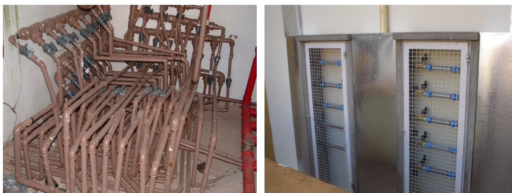
Figura 2: Exemplos de soluções inadequadas para a individualização da medição de água em edifícios existentes.
