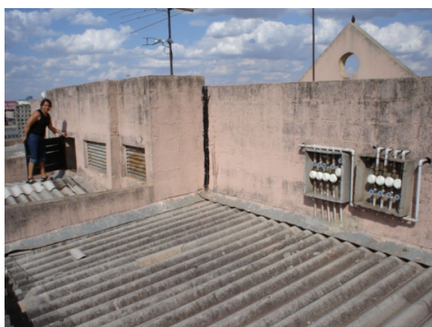
Hidrômetros localizados na cobertura
