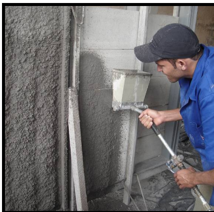
Figura 2 – Aplicação dos revestimentos de argamassa.
