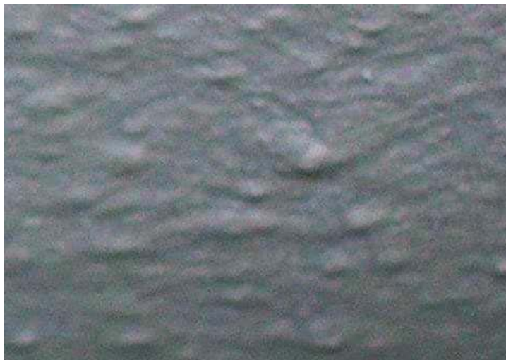
Foto 9 – Empolamento Rígido de Revestimento
