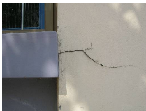
Foto 4 – Trinca por Ausência de Contra-verga
