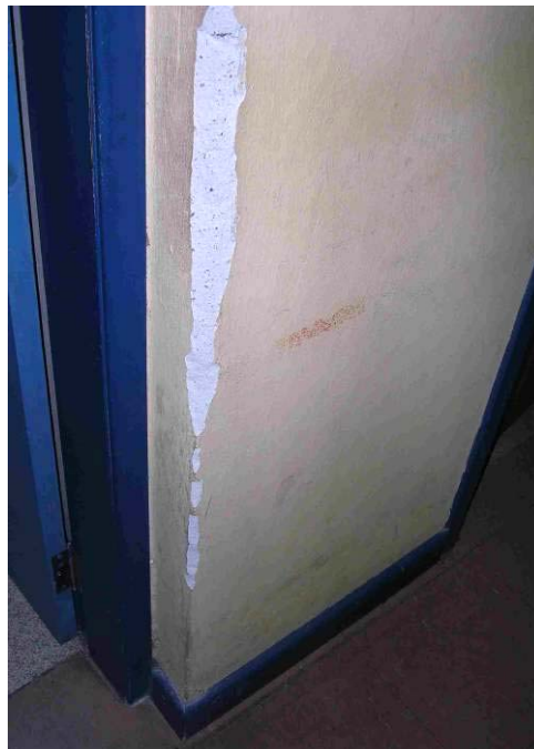
Fotos 5 e 6 – Descolamentos Superficiais de Revestimentos de Argamassa
