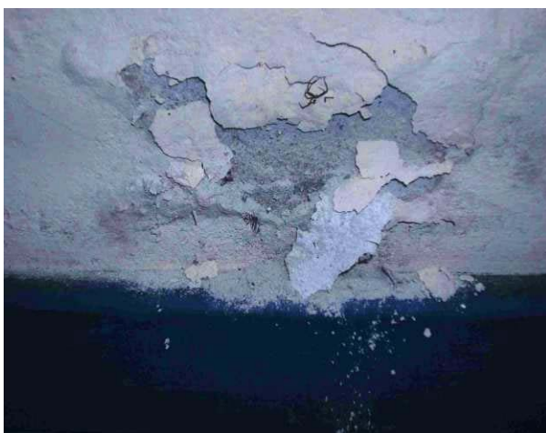
Fotos 7 e 8 – Descolamentos Profundos de Revestimentos de Argamassa
