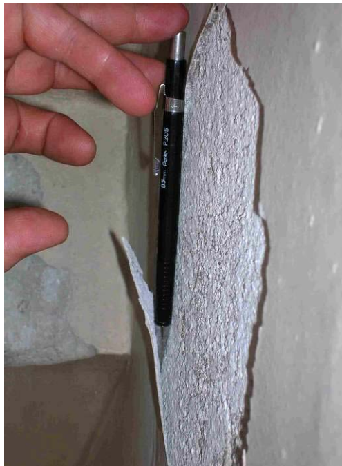
Fotos 5 e 6 – Descolamentos Superficiais de Revestimentos de Argamassa
