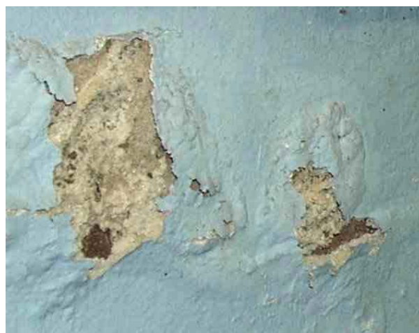
Fotos 7 e 8 – Descolamentos Profundos de Revestimentos de Argamassa
