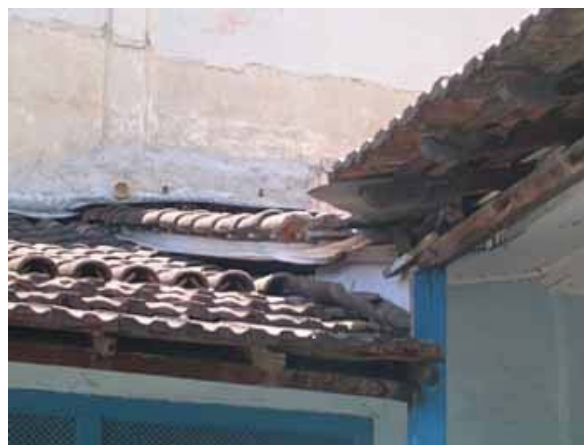
Fig.17 Transpasse entre telhas. Foto dos autores, 2007
