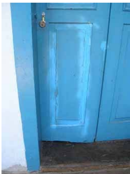
Fig.14 Reparos em esquadrias. Foto dos autores, 2007
