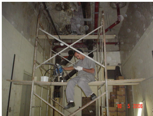
Fotos 9 e 10 – Impermeabilização da laje de piso da lavanderia, Hospital – RJ, Zapla (2006)
