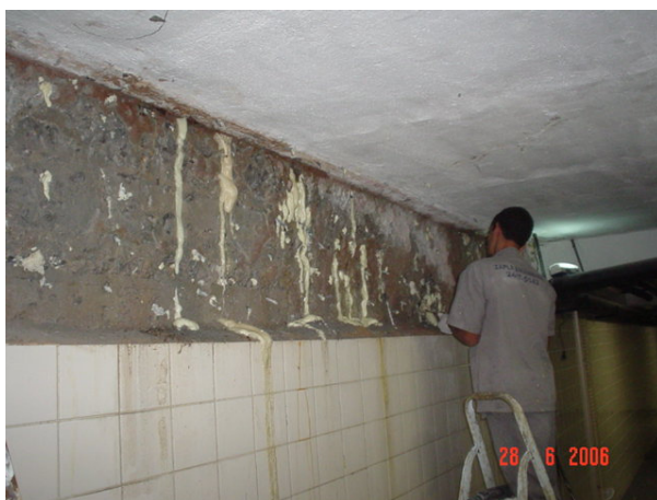
Fotos 1 e 2 – Impermeabilizando parede diafragma 2º subsolo, Ed. Residencial -RJ, Zapla (2006)
