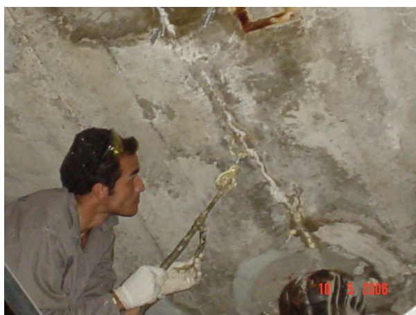
Fotos 11 e 12 -Impermeabilização da laje de piso da lavanderia, Hospital – RJ, Zapla (2006)
