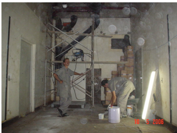
Fotos 9 e 10 – Impermeabilização da laje de piso da lavanderia, Hospital – RJ, Zapla (2006)
