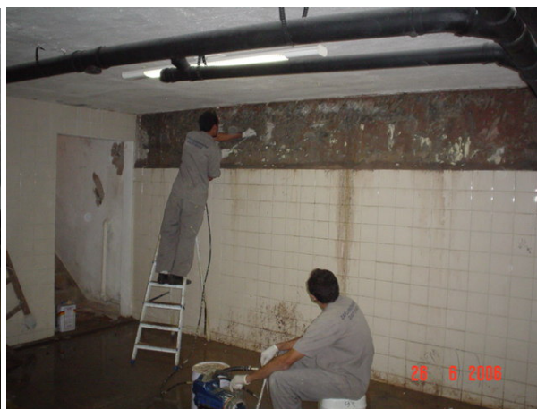
Fotos 1 e 2 – Impermeabilizando parede diafragma 2º subsolo, Ed. Residencial -RJ, Zapla (2006)
