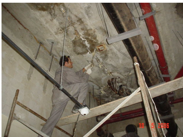
Fotos 11 e 12 -Impermeabilização da laje de piso da lavanderia, Hospital – RJ, Zapla (2006)
