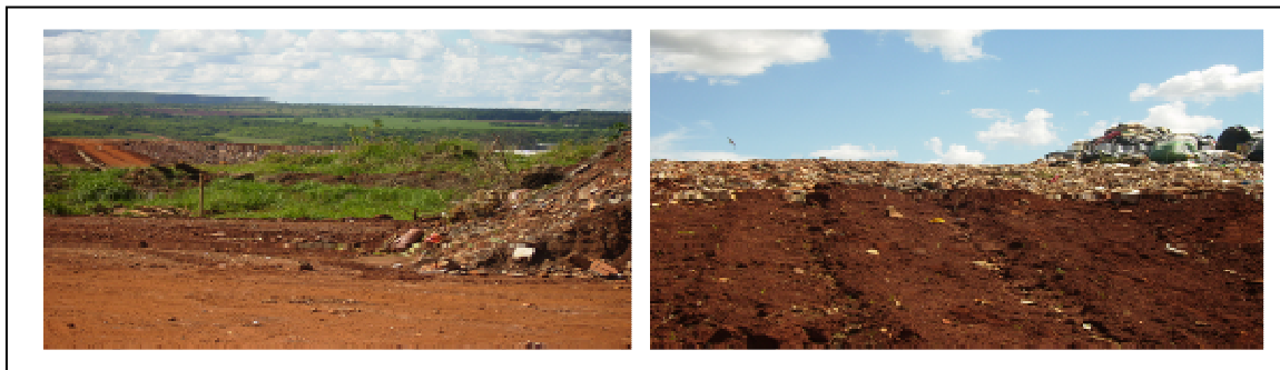
FIGURA 5 – RCD no aterro sanitário utilizado como cobertura do resíduo domiciliar.
