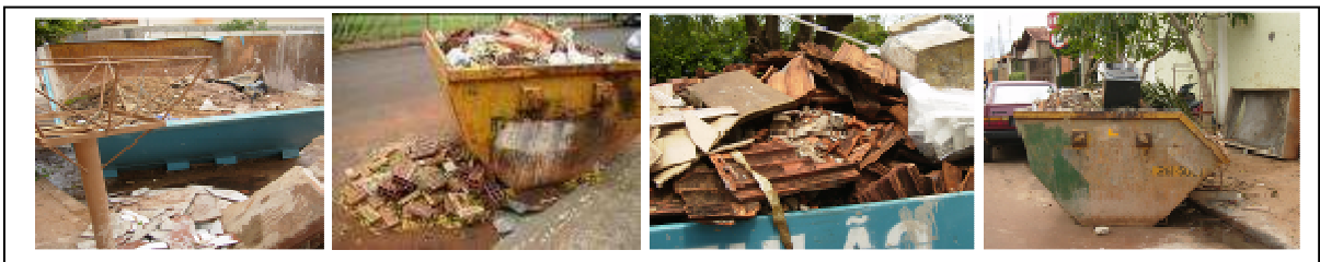
FIGURA 8 – RCD depositados fora das caçambas, caçamba com volume depositado acima de sua capacidade e falta de sinalização na caçamba.
