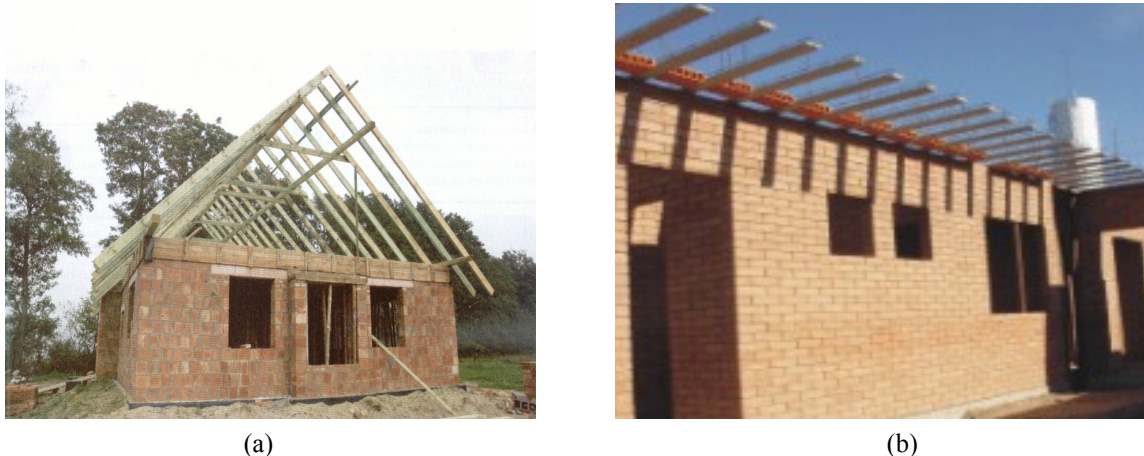
Figura 1 – Blocos cerâmicos tradicionais (a) e blocos de solo-cimento dispensando revestimento externo (b)
