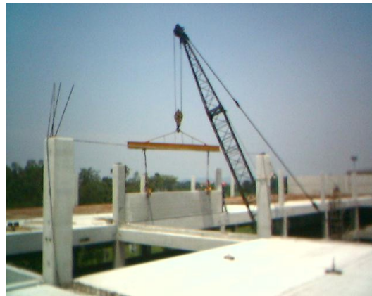
Figura 5 – Montagem de peças pré-fabricadas. Instituto de Física/UFRJ (Foto do autor).
