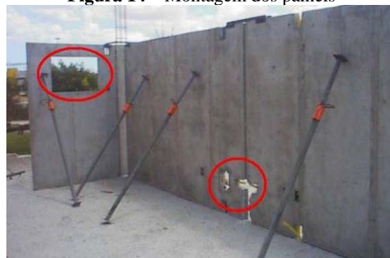
Figura 16 – Escoras dos painéis, detalhe para o vão das janelas e dutos previamente instalados nos painéis
