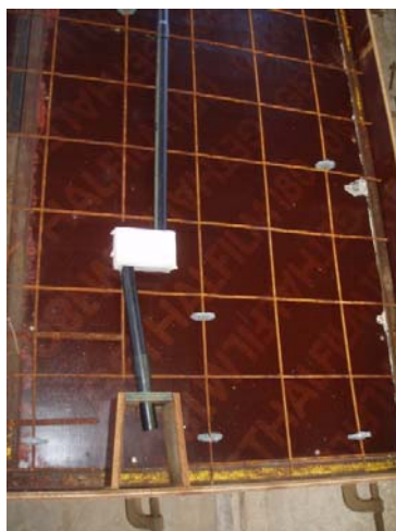
Figura 9 – Dutos e caixas de eletricidade.
