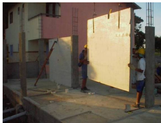
Figura 14 – Montagem dos painéis
