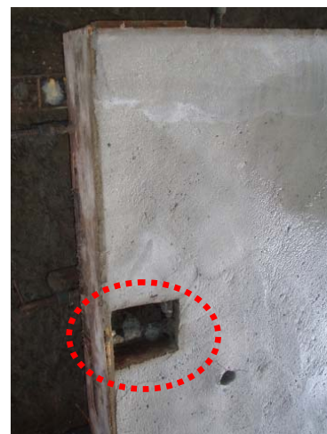
Figura 10 – Detalhe do espaço para conexão da tubulação.
