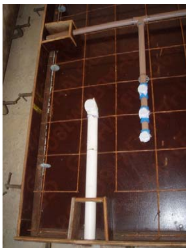
Figura 8 – Tubulação de água e esgoto.
