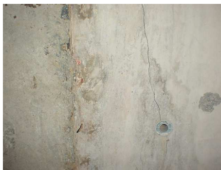
Figura 7 – Brocas e emenda de concretagem
