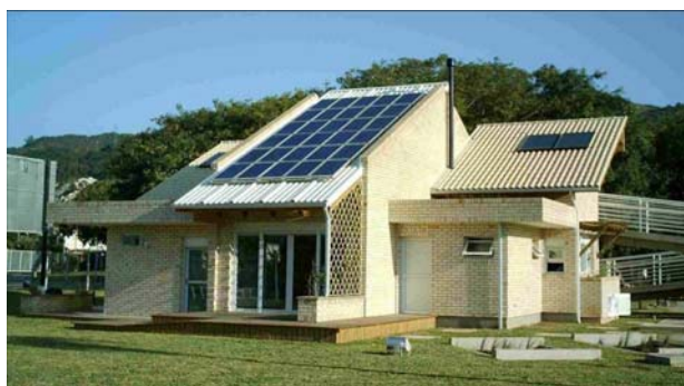
Figura 3 – Vista externa da Casa Eficiente, observando-se o painel fotovoltaico (cobertura central) e coletores solares orientados a Norte.
