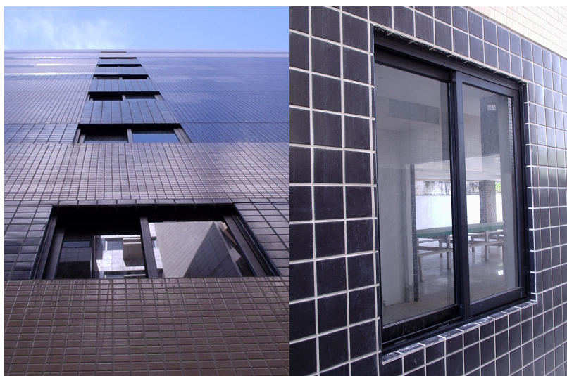
Figura 4 – Revestimento das fachadas e esquadrias utilizadas no edifício Cittá di Pontrêmolí - Cerutti Engenharia. Fonte: arquivo pessoal. 09/11/2006
