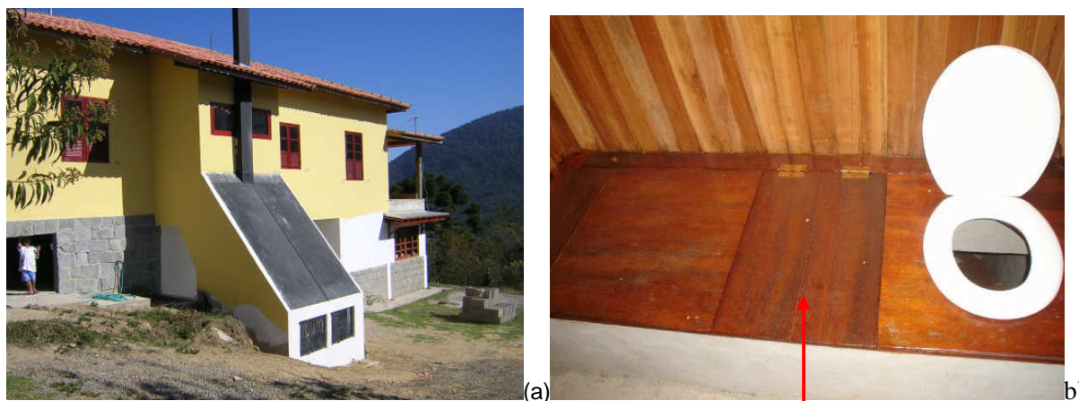
Fotos 2 – “bason” do TIBÁ (a), assento e compartimento para colocação da serragem - SeteLombas (b)
