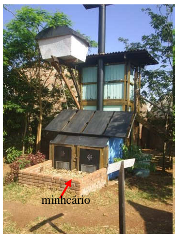
Fotos 3 – Sanitário seco compostável com minhocário, e aquecimento solar para o chuveiro (a), (b) e (c)
