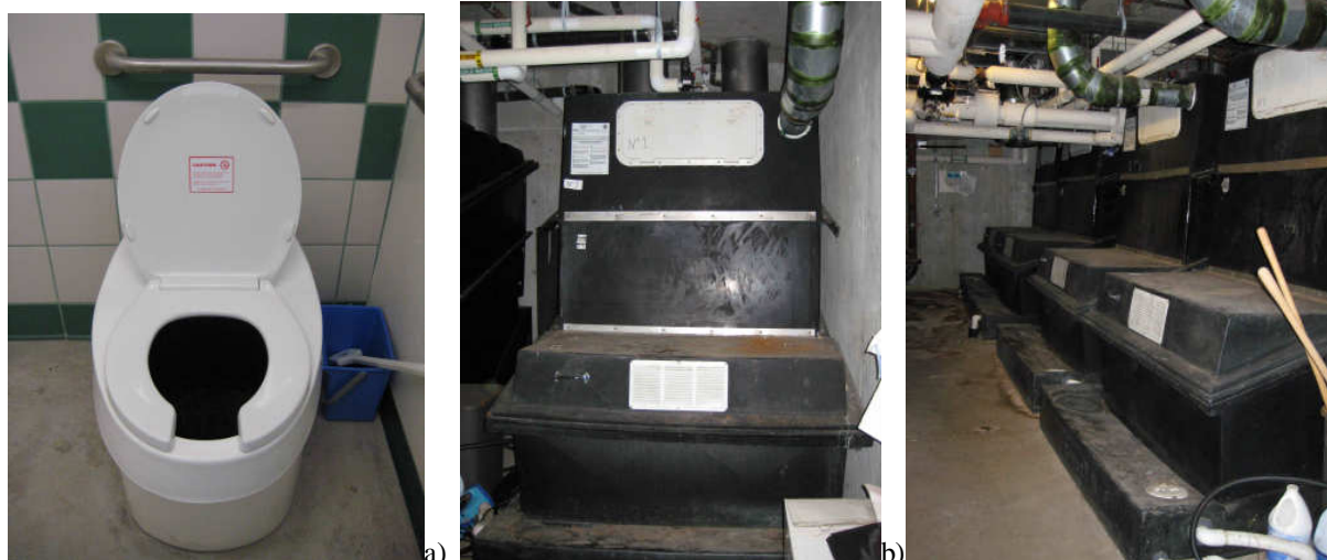
Fotos 1 – vaso sanitário (a), câmara de compostagem industrializada (b) – Instalações do C.K. Choi Building- Institute of Asian Research, University of British Columbia, Vancouver, Canadá.
